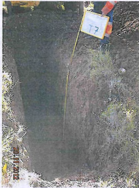
Figura 5 – Documentazione fotografica delle trincee esplorative
